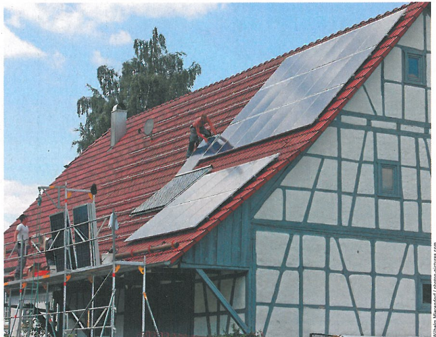
Installation einer Solarstromanlage: Bestandteil des Gebäudes?
